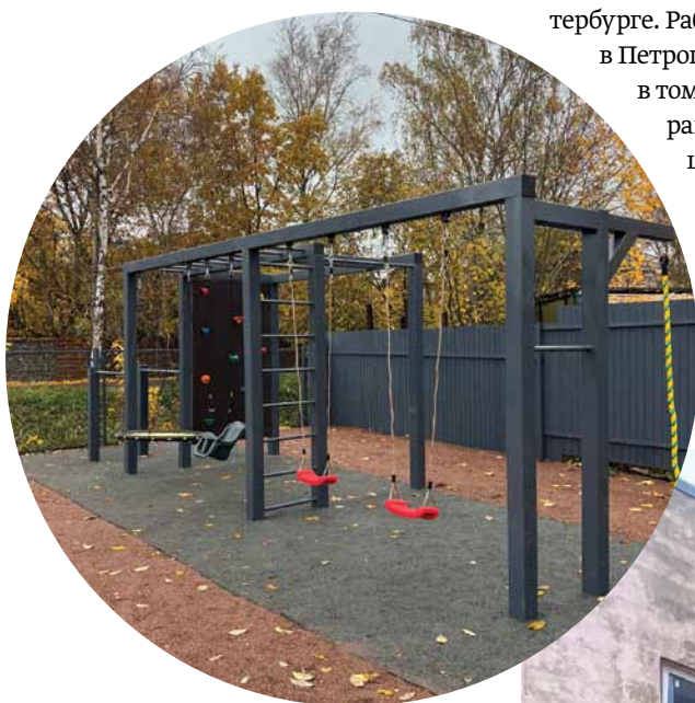
Детская площадка с покрытием из резиновой крошки и пенополиуретанового клея
